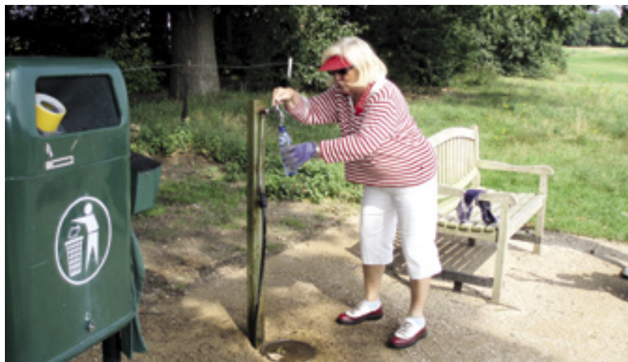
Ook op de servicepunten is een stabiele toplaag met Stabicol aangebracht.
